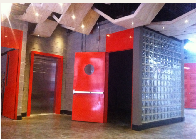
Circulaciones · Hall del primer piso con ascensor y puerta cortafuego · Referencia anterior a 2019
